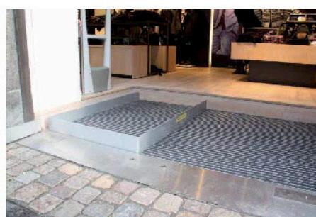
Situados en todos los laterales abiertos para garantizar la seguridad del usuario. Los zócalos también actúan como sistema de bloqueo: se elevan 100mm hacia arriba antes que el elevador empiece a moverse.
